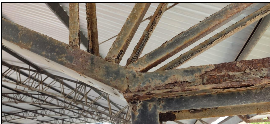
Figura 5: Banzos, Diagonais e Montantes
