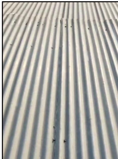
Figura 12: Parafusos e Furos nas Telhas
