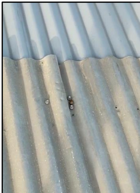
Figura 12: Parafusos e Furos nas Telhas
