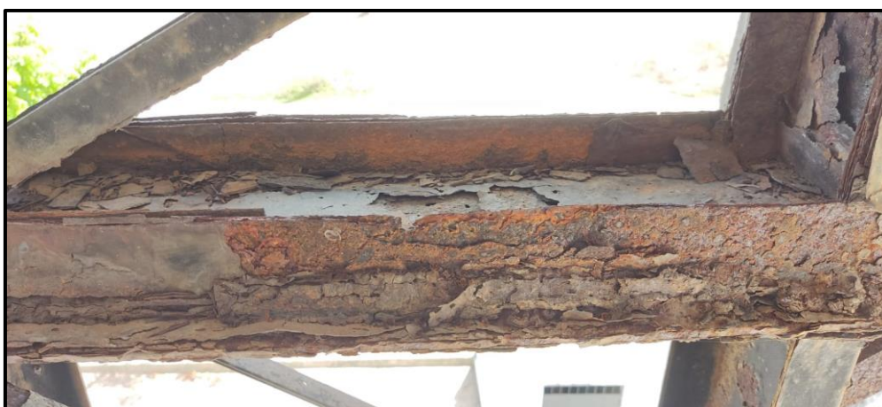
Figura 4: Banzo Inferior da Tesoura
