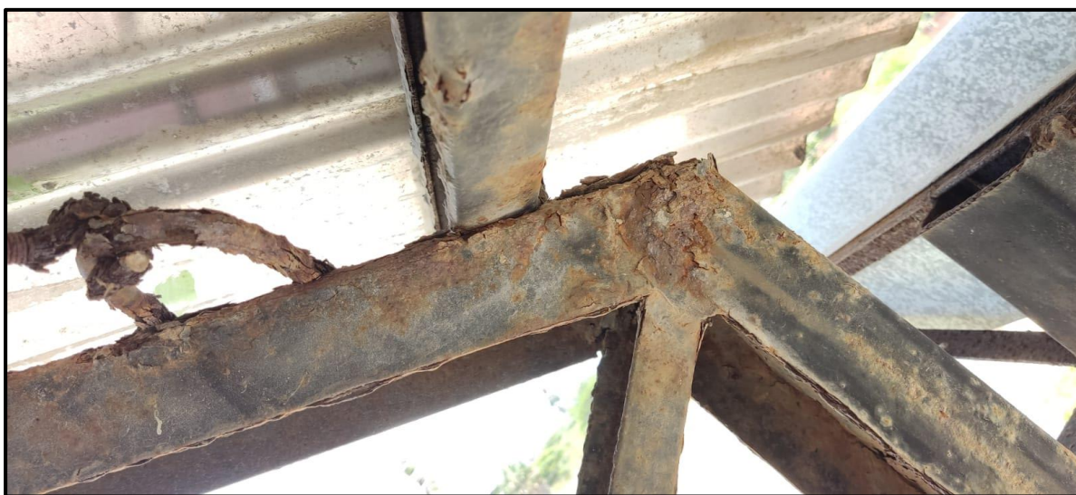
Figura 8: Ligação Contraventamento, terço , banzo, montante e diagonais
