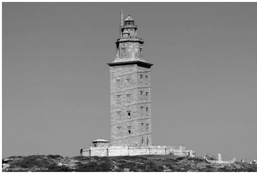
Faro Torre Hércules (La Coruña)
