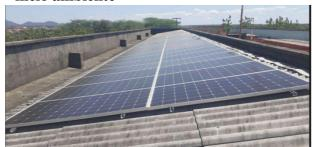
Foi instalado um sistema de energia fotovoltaica de 18,48 kwp no campus com o objetivo de reduzir os gastos com energia e obter o bem de forma limpa e sustentável.
